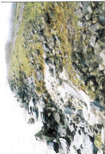
Poškodená hrádza vodnej nádrže Zemplínska šírava po mimoriadne silnej búrke v noci z 5. na 6. apríla v roku 2000
