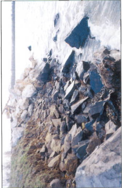
Poškodená hrádza vodnej nádrže Zemplínska šírava po mimoriadne silnej búrke v noci z 5. na 6. apríla v roku 2000
