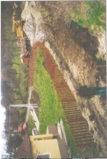
Výstavba oporného múru na spevnenie južného svahu hlavnej cesty E - 50 (rok 2001)
