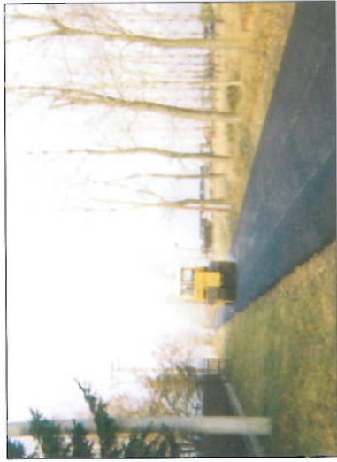
Kladenie asfaltového koberca na "panelovú cestu" k Zemplínskej šírave v roku 1995
