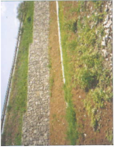
Výstavba oporného múru na spevnenie južného svahu hlavnej cesty E - 50 (rok 2001)
